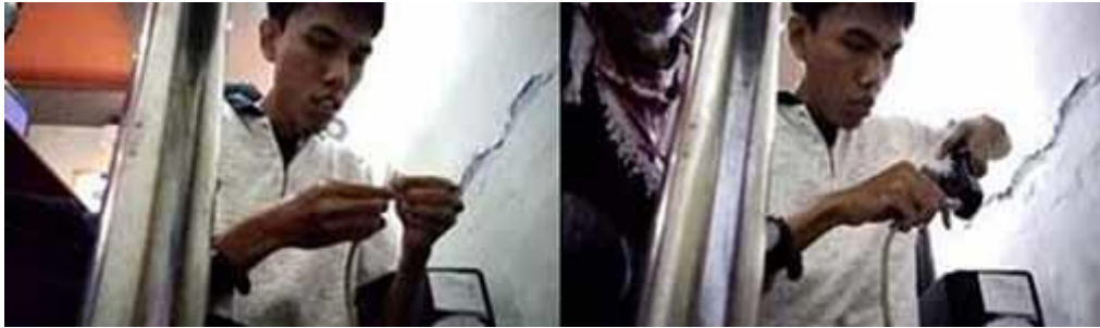
Gambar 3.16. Proses instalasi kabel LAN yang digunakan untuk menghubungkan router dengan router dan komputer atau laptop lainnya.
